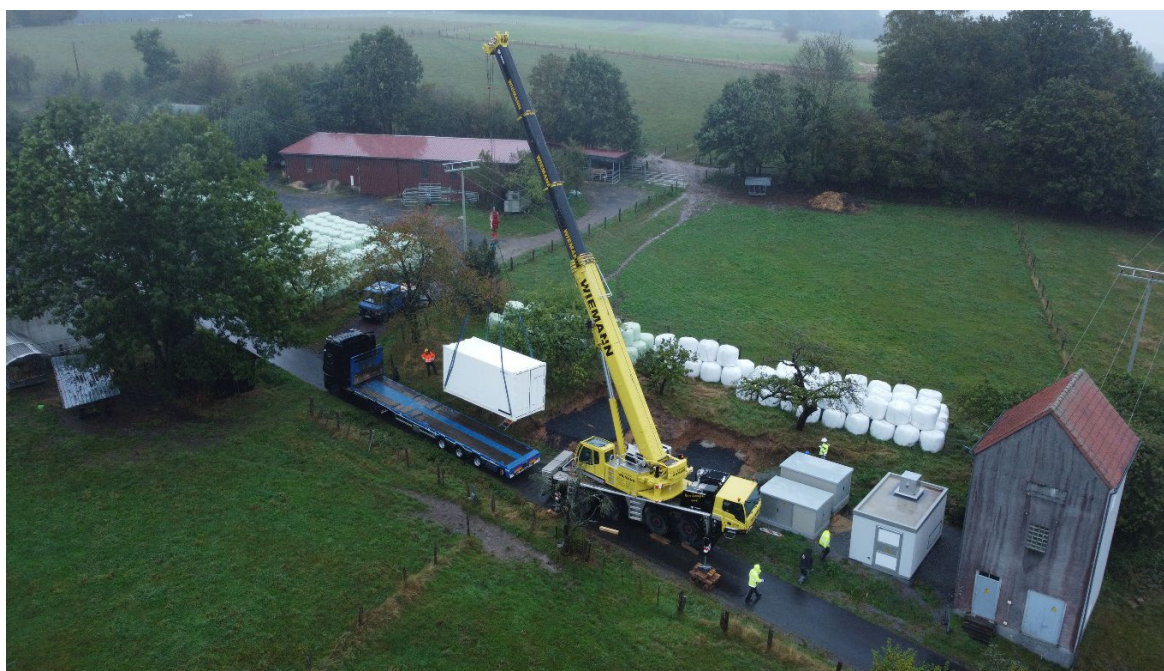
Aufstellung des ersten Batteriespeichercontainers am Standort Heubach (Rhön)
